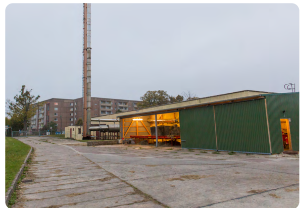
Abb. 3.2: Heizwerk der Agrotherm GmbH in Malchin, wo Biomasse aus einem wiedervernässten Niedermoor verbrannt wird. Fotos: T. Dahms
