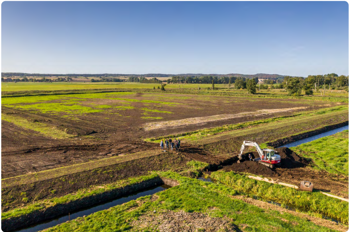
Abb. 2.1: Verwallung zur Abgrenzung einer Rohrkolbenkultur, davor Außengraben zum weiterhin entwässerten Grünland (rechter Bildrand). Foto: T. Dahms, 2020). Die Verwallung hat eine 3 m breite Krone und Auffahrten mit abgeflachter Böschung an mehreren Stellen. Die Verwallung wird regelmäßig gemäht, der zum Abhalten von Schwarzwild auf der Verwallung gesetzte E-Zaun wird ebenfalls regelmäßig von Vegetation befreit.
