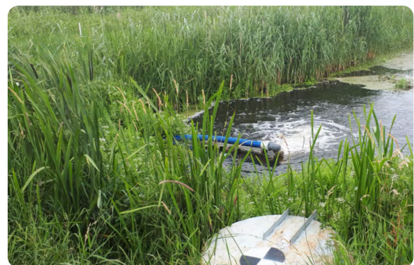
Abb.7.6: Druckrohr und Überlauf. Foto: J. Neubert (2020)
