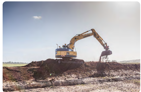
Abb. 7.5: Bau der Verwallung. Foto: T. Dahms (2019)
