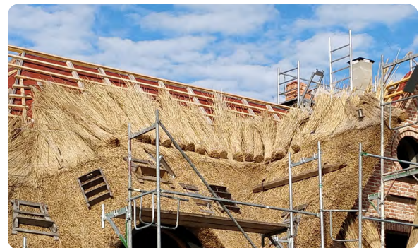
Abb. 3.4: Dachschilf (-Rohr) zur Dachdeckung. Foto: S. Abel
