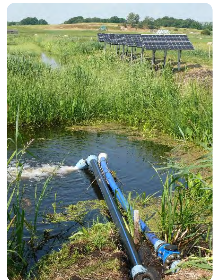
Abb. 2.2: Links: Mahlbusen und Pumpe für Zuwässerung, sowie vorn im Bild – Mönch (Überlauf) zur Regulierung des Wasserstands in einer Rohrkolbenkultur. Rechts: Auslauf Druckrohr Flächeninnenseite und Solarmodule im Hintergrund für den Betrieb der Solarpumpe (Fotos: J. Neubert, 2022; siehe auch Kapitel 7.1). Um den Wasserstand zu kontrollieren, sind regulierbare Wehre, Pumpen (mobil oder stationär) inkl. Energieversorgung (Solarmodule, Windrad, Dieselgenerator o. Stromanschluss) notwendig.
