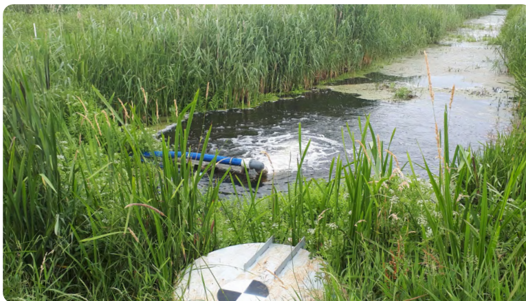
Abb. 2.2: Links: Mahlbusen und Pumpe für Zuwässerung, sowie vorn im Bild – Mönch (Überlauf) zur Regulierung des Wasserstands in einer Rohrkolbenkultur. Rechts: Auslauf Druckrohr Flächeninnenseite und Solarmodule im Hintergrund für den Betrieb der Solarpumpe (Fotos: J. Neubert, 2022; siehe auch Kapitel 7.1). Um den Wasserstand zu kontrollieren, sind regulierbare Wehre, Pumpen (mobil oder stationär) inkl. Energieversorgung (Solarmodule, Windrad, Dieselgenerator o. Stromanschluss) notwendig.
